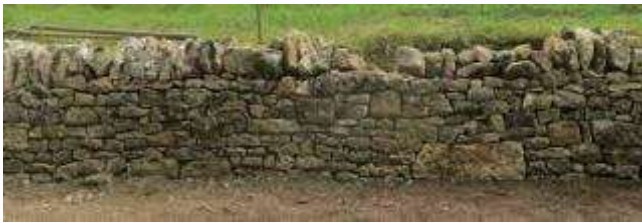
Mur en pierre sèche
